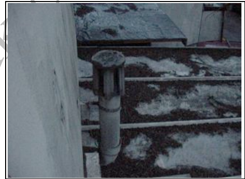
Asbestos flue
